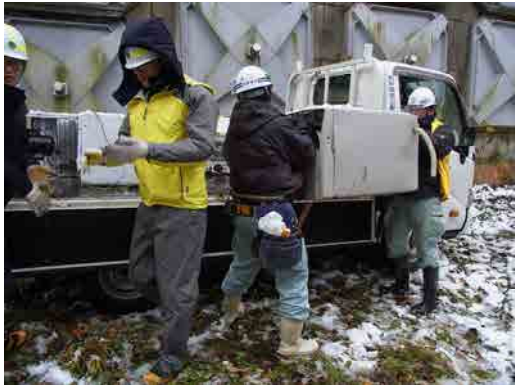
(積み込み作業)
