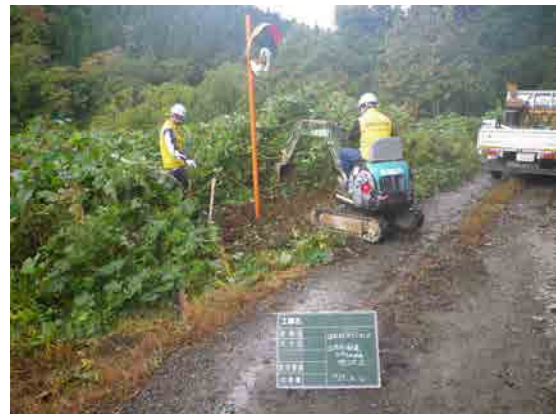
カーブミラーの設置作業
