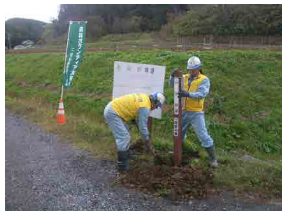
倒れた標識の補修
