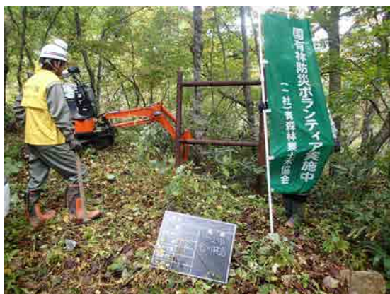
古い標識を撤去、改修
