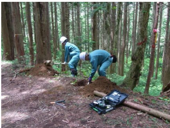
説明板設置用の穴掘り
