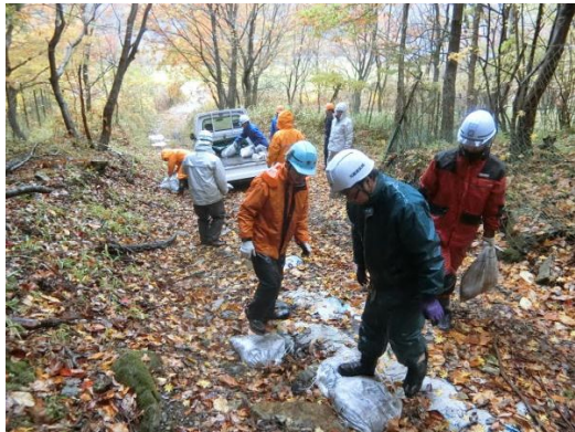
作業道の補修作業
