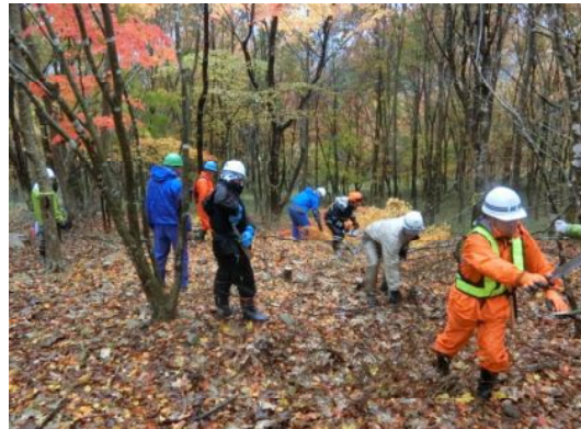
埋設箇所付近を整理
