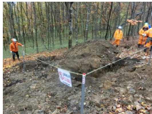
最後に転落防止柵と注意票の設置
