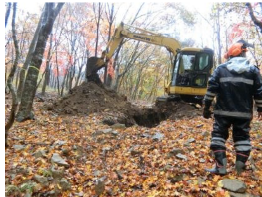
会員企業の重機による埋設穴の掘削作業
