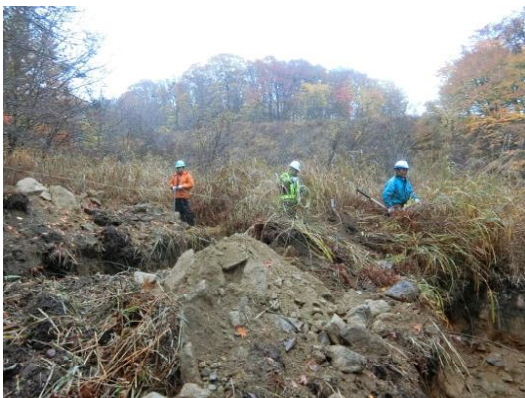
埋設穴付近を整理
