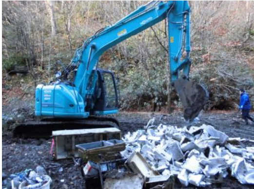
バックホウによるゴミの掘り出し
