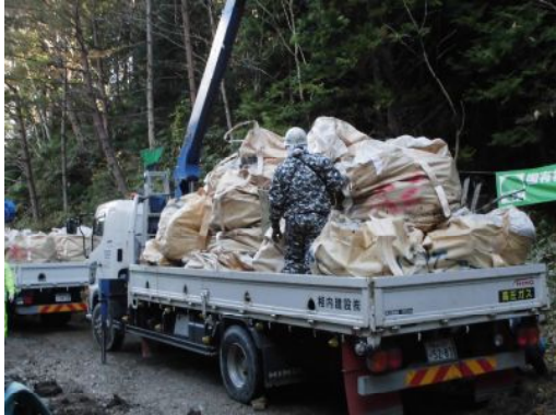
トラックへ積み込み
