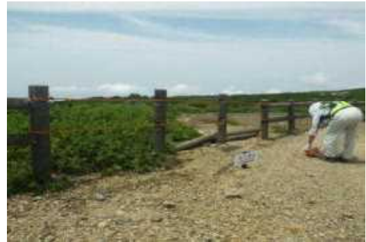
(補修後の立入禁止柵)
