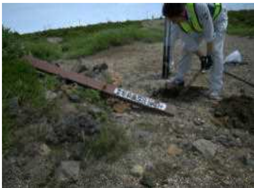
(倒れた標柱の補修作業)
