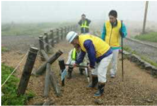
(立入禁止柵の補修作業)
