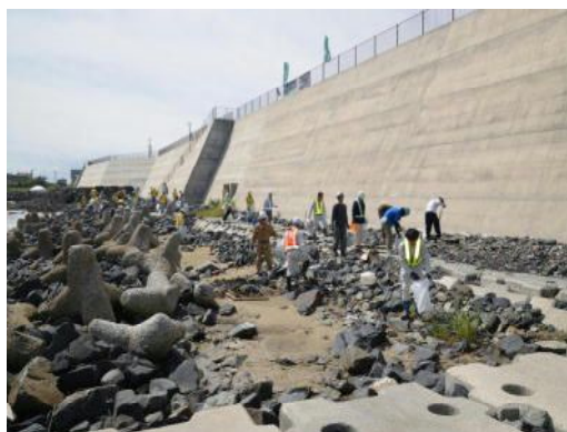
(回収作業の状況)
