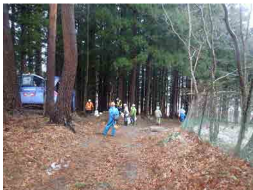
(作業道修繕のための土のう作成状況)
