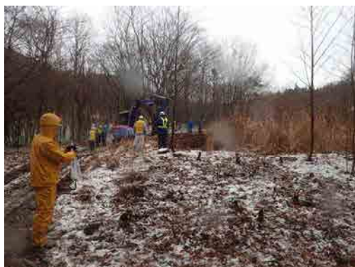
(埋設穴掘削状況)
