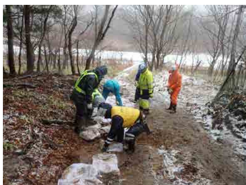
(作業道の修繕状況)
