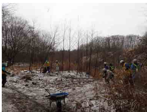
(埋設穴設置箇所の枝払い状況)
