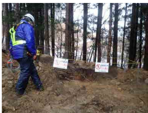
(埋設穴掘削後の柵の設置状況)
