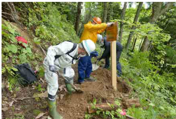
しっかりと埋設
