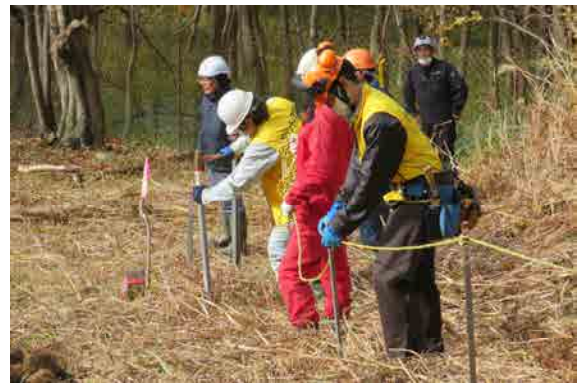
転落防止措置
