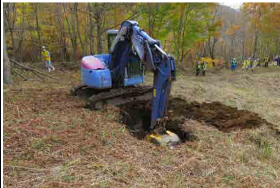
埋設穴の掘削
