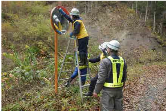
カーブミラーの清掃作業
