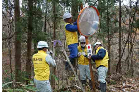
カーブミラーの取り替え作業
