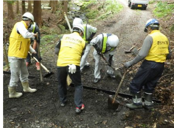
シスイエースの設置作業
