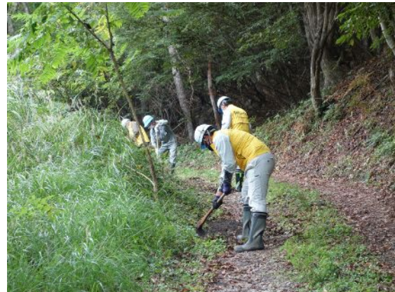
林道の修繕作業
