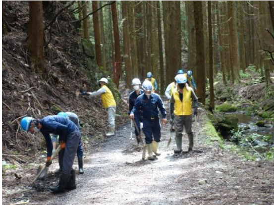
林道の修繕作業
