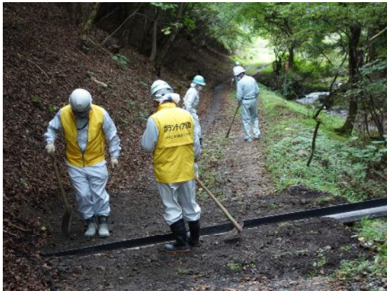
シスイエースの設置作業
