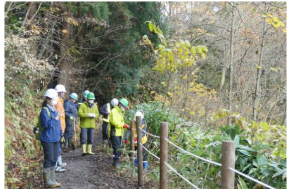
安全ロープの敷設
