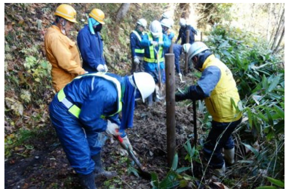
標示杭の埋設作業
