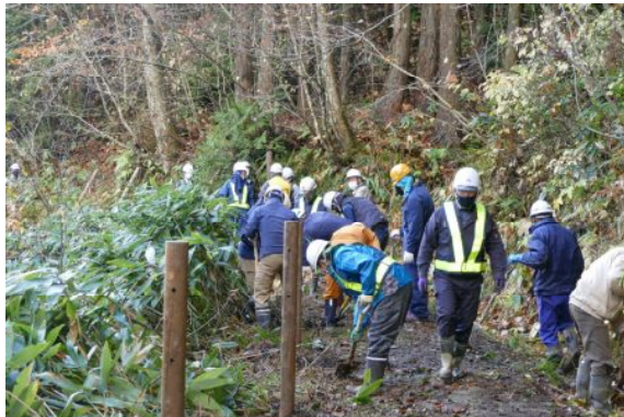
標示杭の埋設作業
