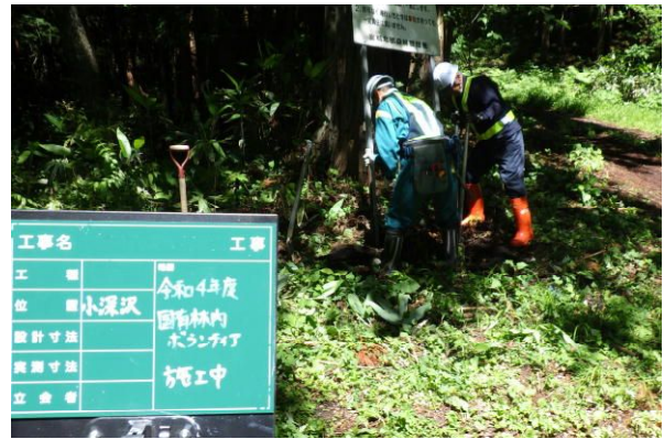
小深沢林道での作業状況
