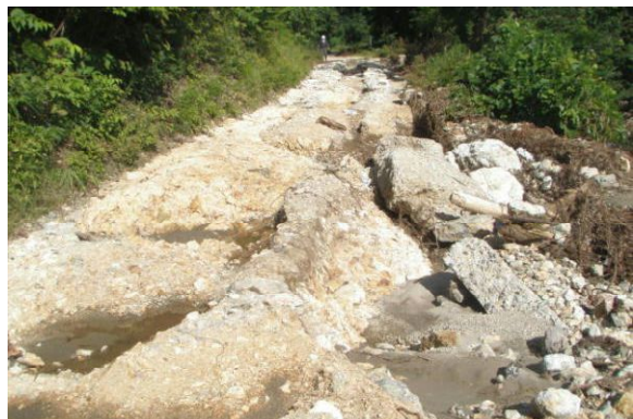
林道の洗掘状況（写真：金木支署提供）
