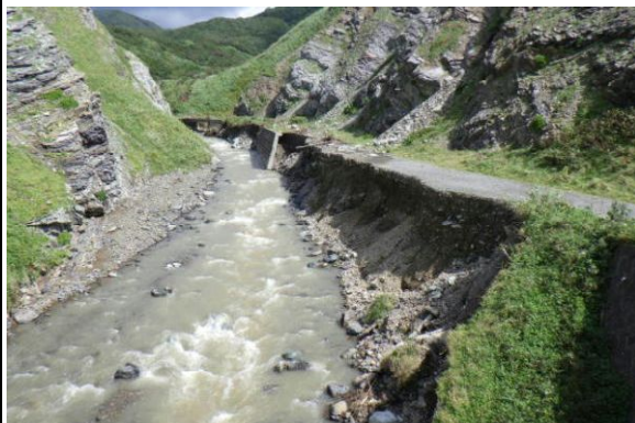
林道の洗掘状況（写真：金木支署提供）
