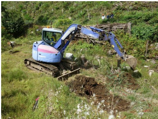
重機による埋設穴の掘削作業
