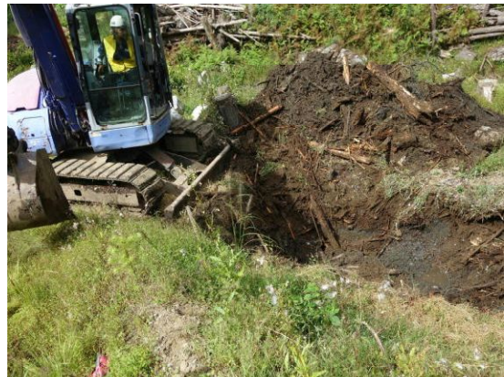
重機による埋設穴の掘削作業
