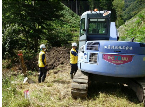
埋設穴の掘削
