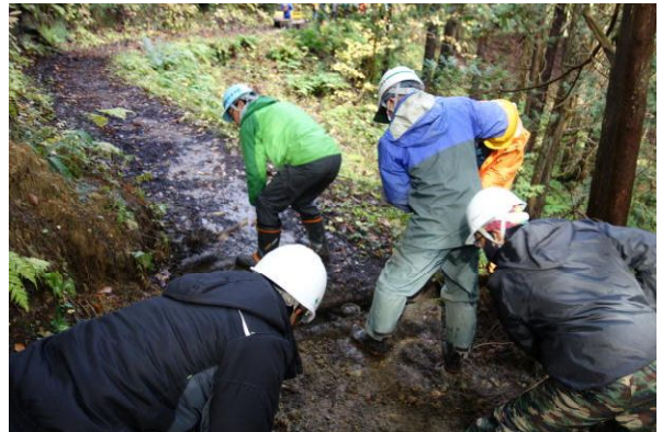
排水施設の土砂除去作業
